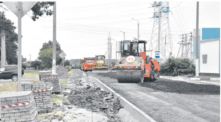
Ремонт дороги ул. Чкалова п. Прохоровка
