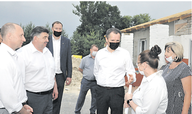
Посещение ремонтируемого детского сада «Лучик» с. Прелестное
