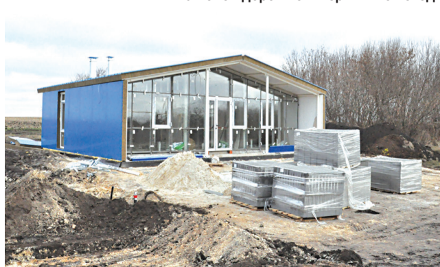
Строящийся ФАП в х. Калинин
