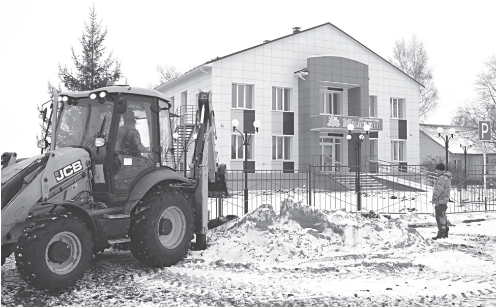
Строители с помощью трактора расчищают площадку под будущее асфальтное покрытие подъездного пути
