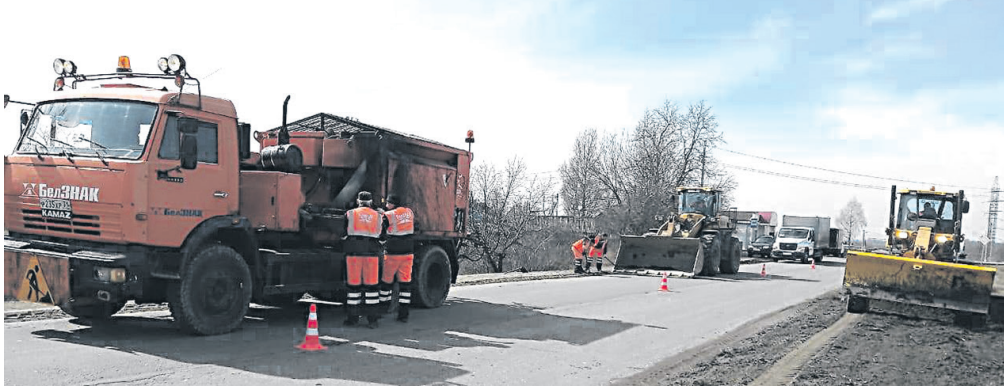
Начался ремонт дороги на улицах Чкалова-Лесная п. Прохоровка
